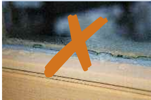
Problemy z utrzymaniem higieny na krawędzi szkła z powodu gromadzenia się wody kondensacyjnej lub pleśni dzięki użyciu SGG SWISSPACER są znacznie zredukowane.
